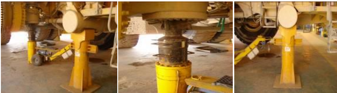
Figura 6.10 Instalación de gata y soporte.
