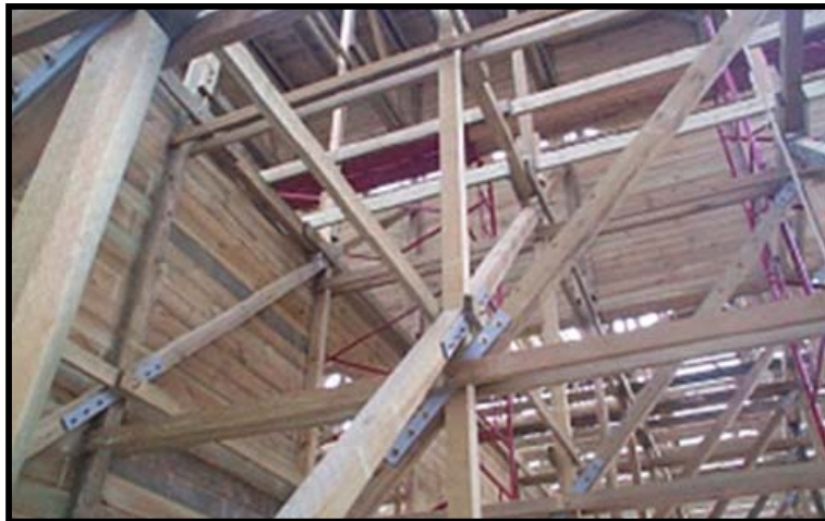
Fig. Nº 7.1 Estructura de la Torre de Enfriamiento.
