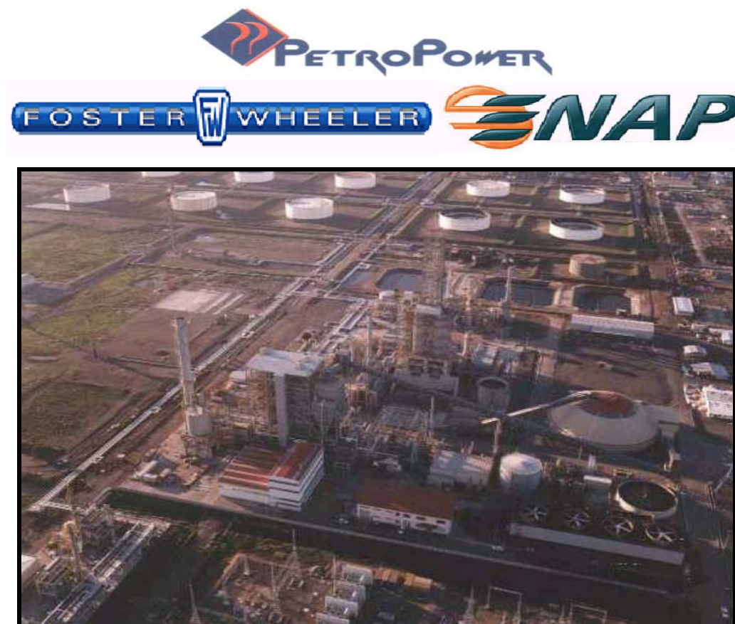
Fig. N° 2.1 PETROPOWER Energía Ltda.
