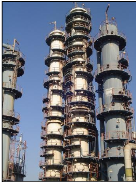
Figura 2.12 Lavadores de gas de coquería.
