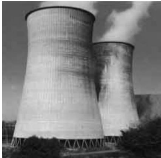
Figura 4.2 Torre de tiro natural o hiperbólica.
