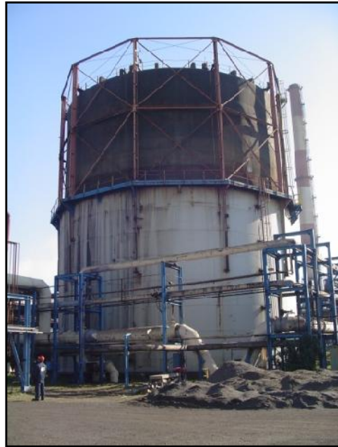
Figura 2.13 Almacenamiento del gas coque.
