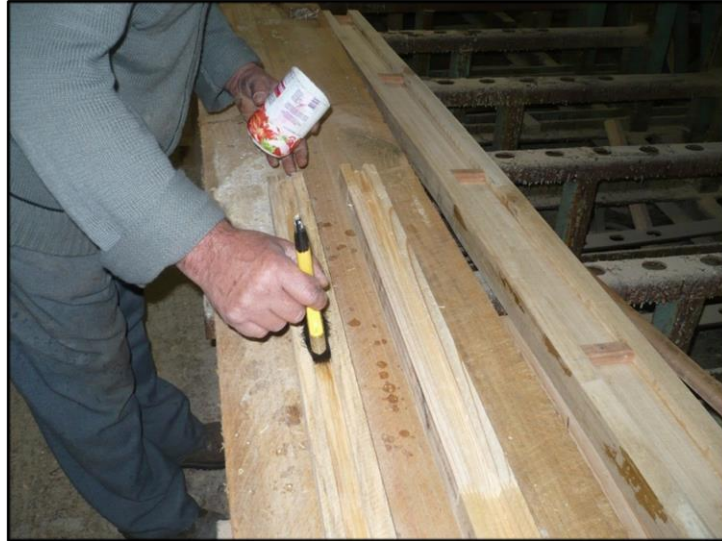
Figura B15: Aplicación del adhesivo.
