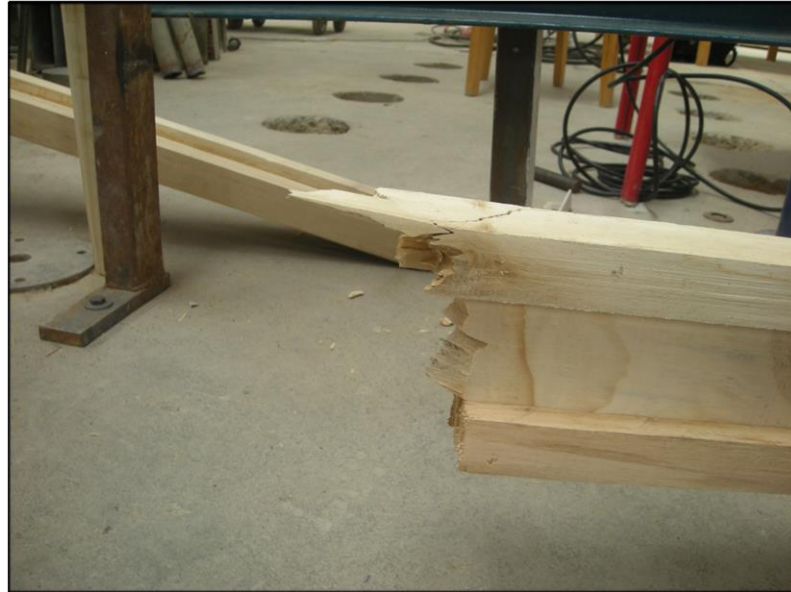
Figura L15: Falla de la unión finger-joint ala inferior (falla primaria).
