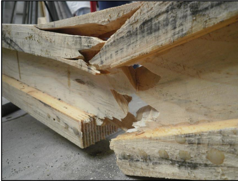
Figura L37: Falla de la unión finger-joint ala inferior (falla primaria).
