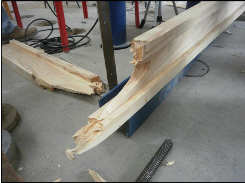
Figura L25: Falla por fractura total (falla primaria).
