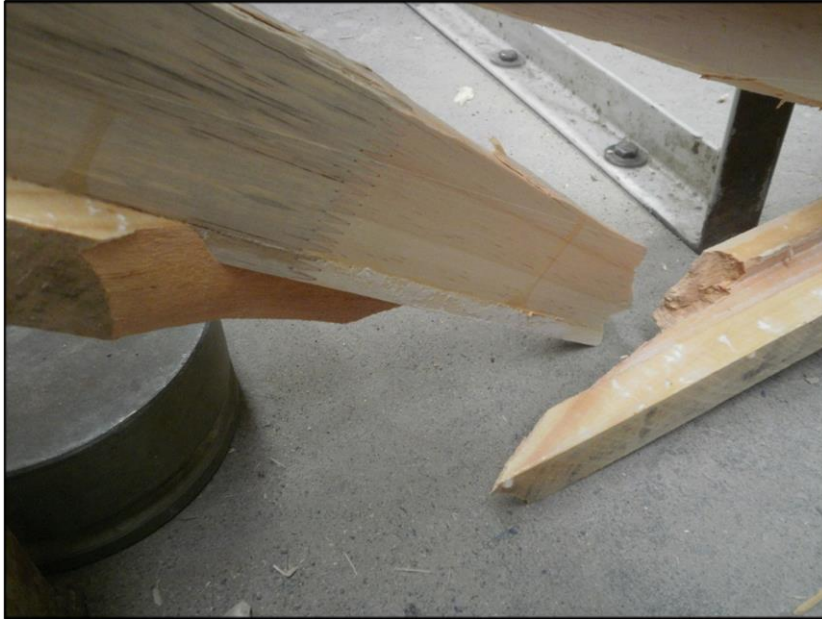
Figura L21: Falla por nudo en el ala inferior (falla primaria).
