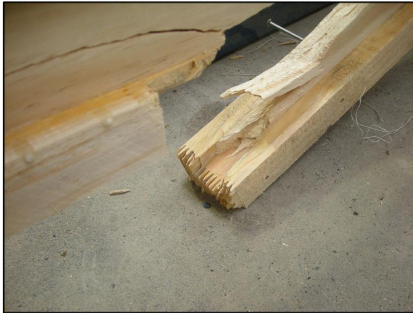
Figura L35: Falla de la unión finger-joint ala inferior (falla primaria).
