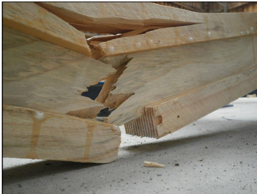
Figura L38: Falla de la unión finger-joint ala inferior (falla primaria).
