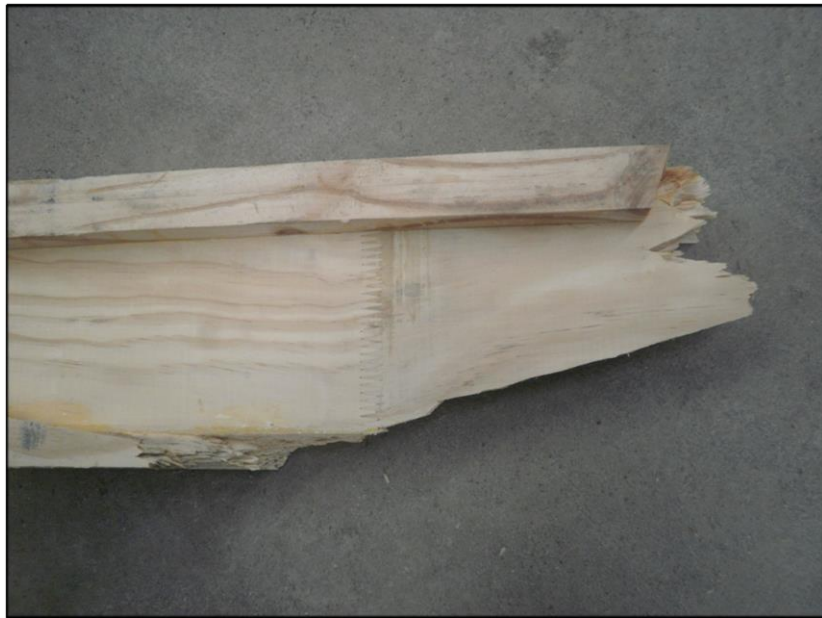
Figura L26: Falla por fractura total (falla primaria).
