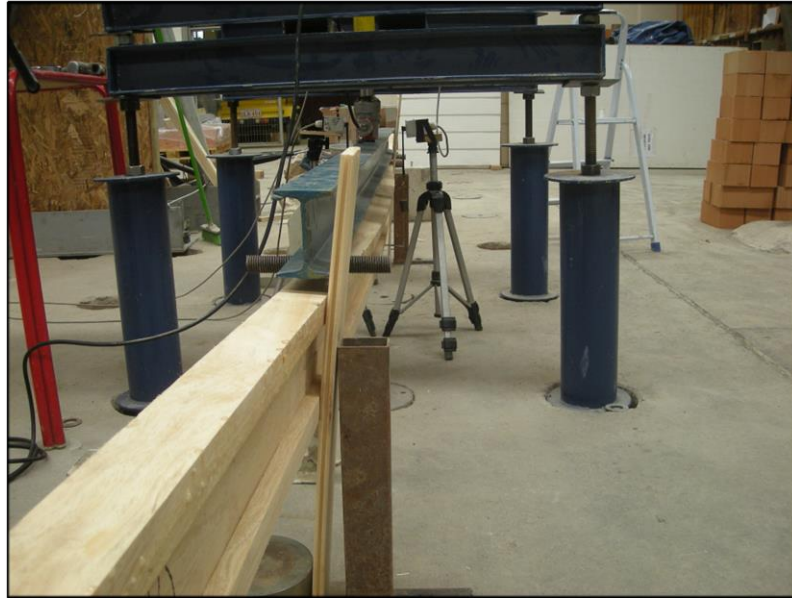
Figura L9: Alabeo antes de la falla de la unión finger-joint del ala superior.
