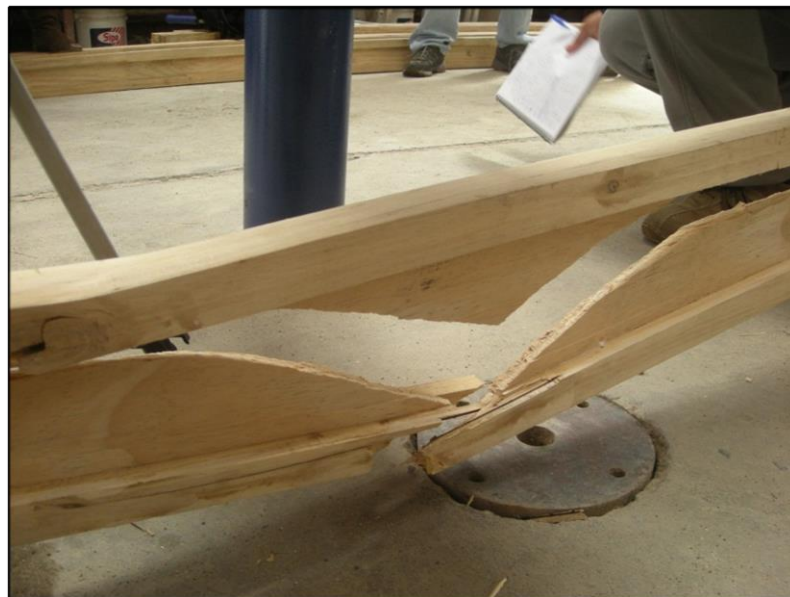
Figura L14: Falla por fractura total (falla primaria).
