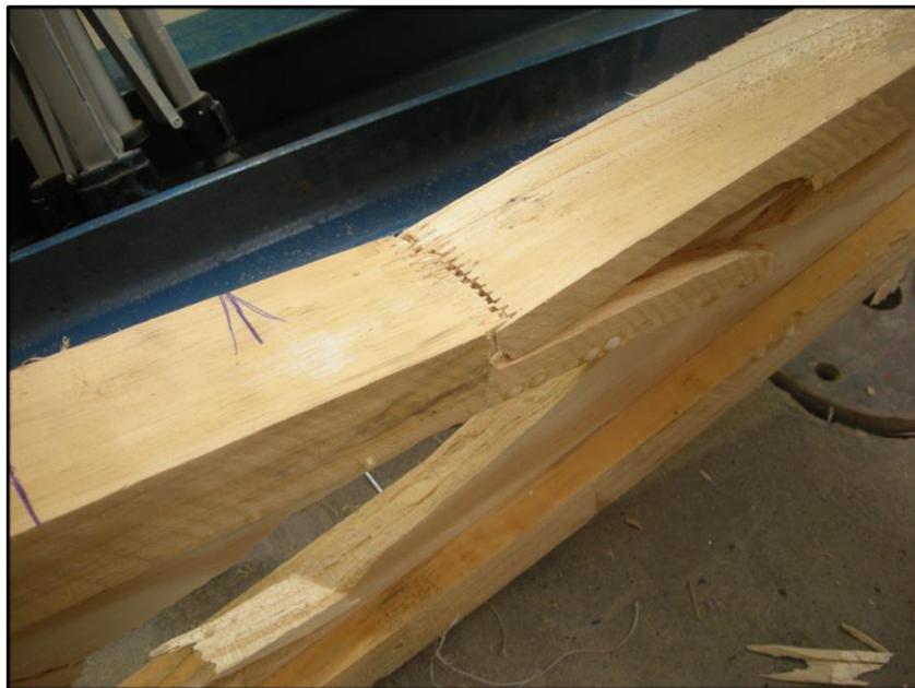
Figura L36: Falla de la unión finger-joint ala superior (falla secundaria).
