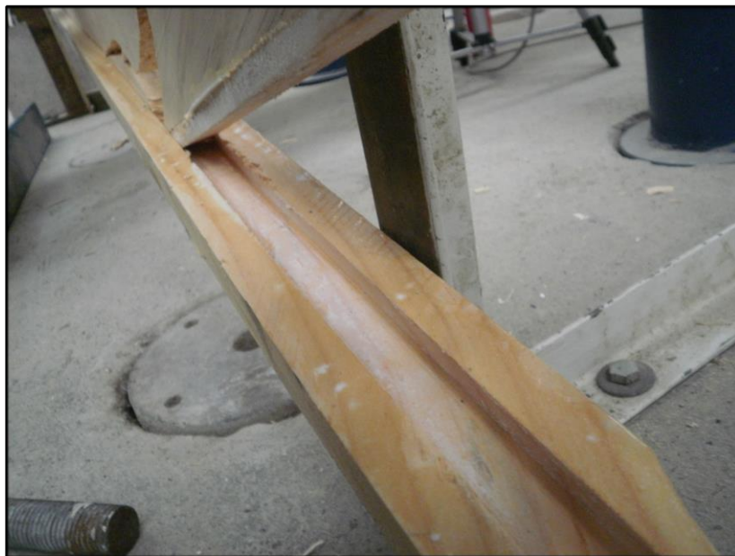
Figura L24: Falla por desprendimiento del alma (falla secundaria)
