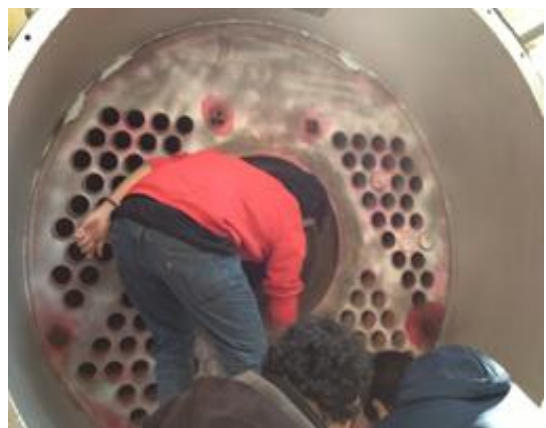
Figura 8.4 Marcado de puntos (sentido horario) para medir espesor en placa de caldera.
