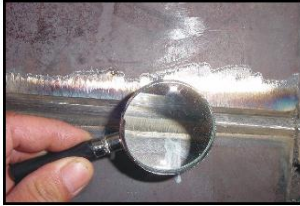
Figura 1.1 Inspección visual de un cordón de soldadura
