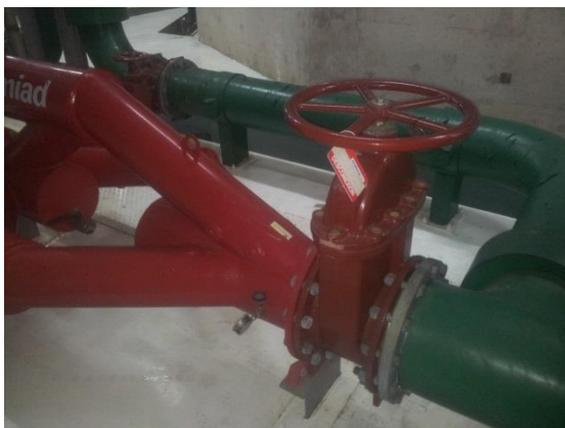
**Foto Nr.2.** Filtro automático (AMIAD 12" ABF DN300 PN16)
