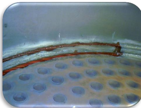
Figura 9.8 Insp. líquidos penetrantes
