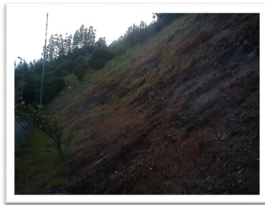
Figura 5: Talud poco erosionado, enlace de ruta Itata con ruta 150. (Fuente: Elaboración propia)
