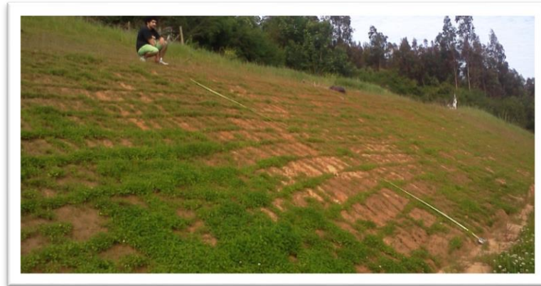
Figura 3: Talud sector río Andalién (Fuente: Elaboración propia)
