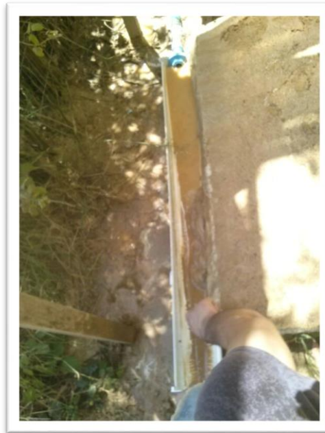
Figura 10: Extracción del material de la canaleta (Fuente: Elaboración Propia)
