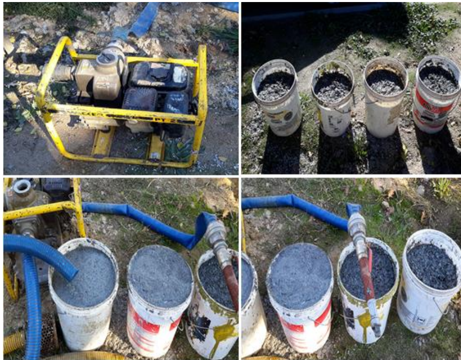
Figura D5: Preparación y mezcla de componentes de la hidrosiembra. (Fuente: Elaboración propia)
