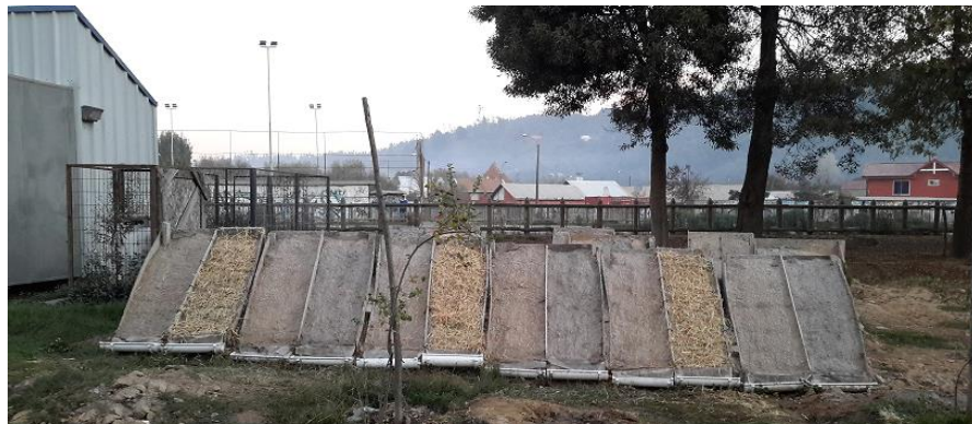
Figura D6: Hidrosiembra aplicada. (Fuente: Elaboración propia)
