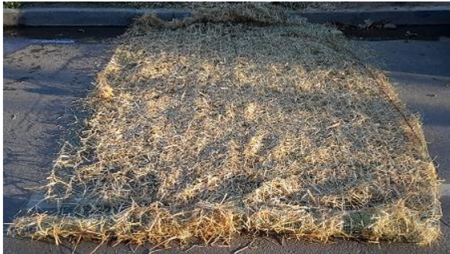
Figura B7: Biomanto en base a paja de trigo utilizado en la hidrosiembra. (Fuente: Elaboración propia.)
