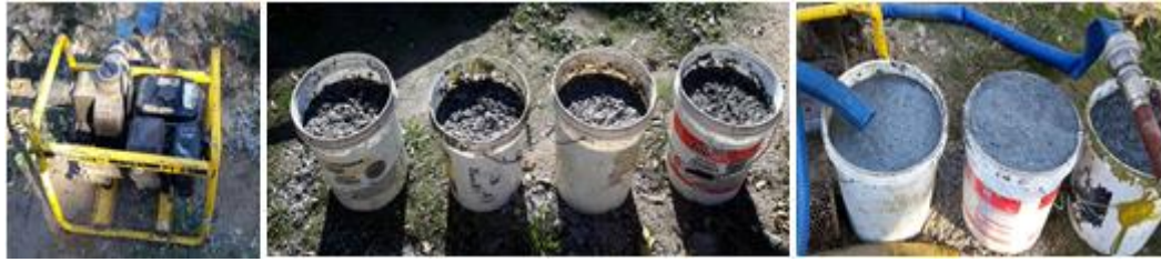
Figura 6. Procedimiento de mezcla de hidrosiembra. (Fuente: Elaboración propia).
