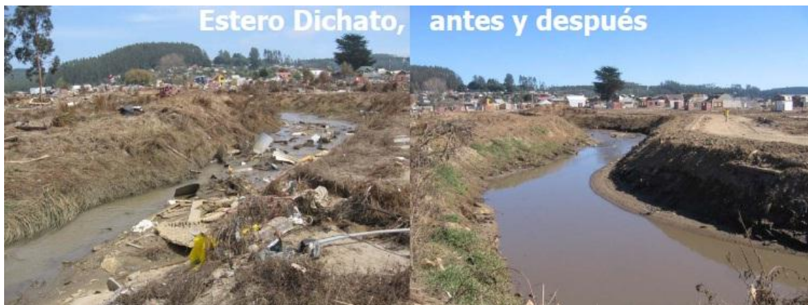
Figura 9: El Antes y Después de las obras de limpieza.
