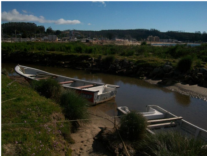
Figura 22: Esguerrimiento aguas abajo 2.
