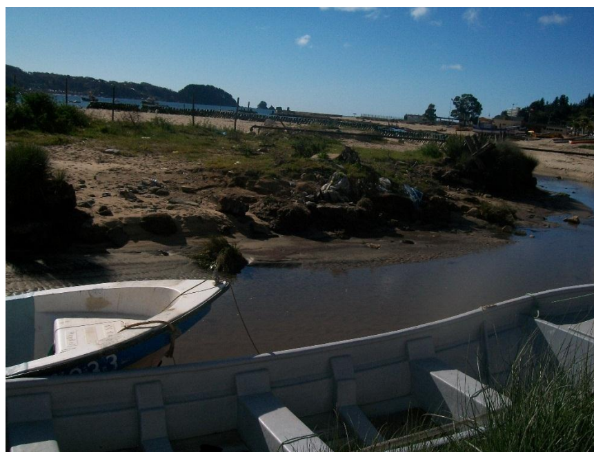
Figura 23: Socavación por choque del oleaje.
