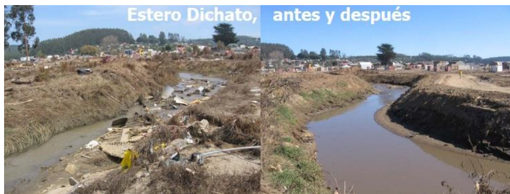
Figura 57: El Antes y Después de las obras de limpieza.
