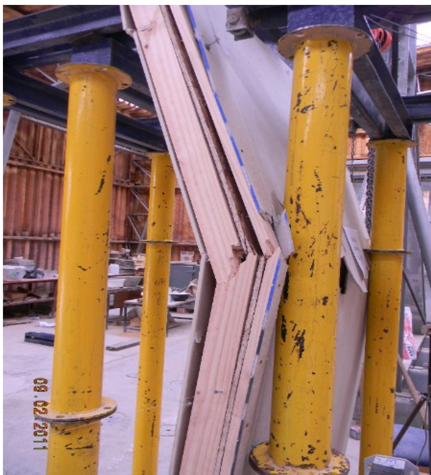
Figura C.2.3. Modo de falla a rotura ensayo compresión muro.
