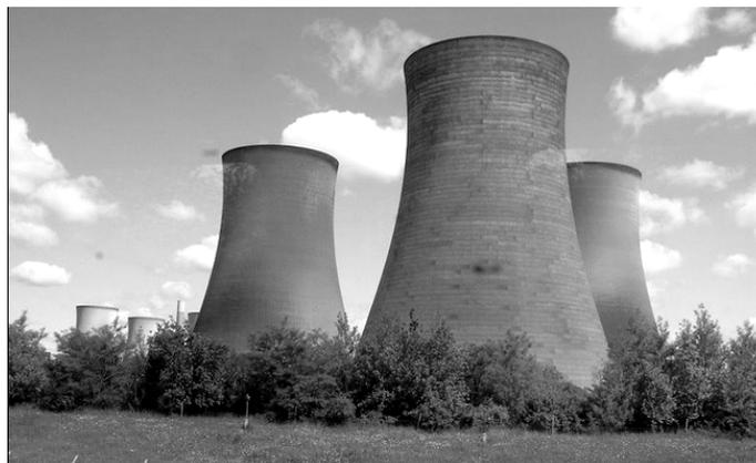
Figura 2.2. Torres de enfriamiento de tiro natural en una central nuclear.
