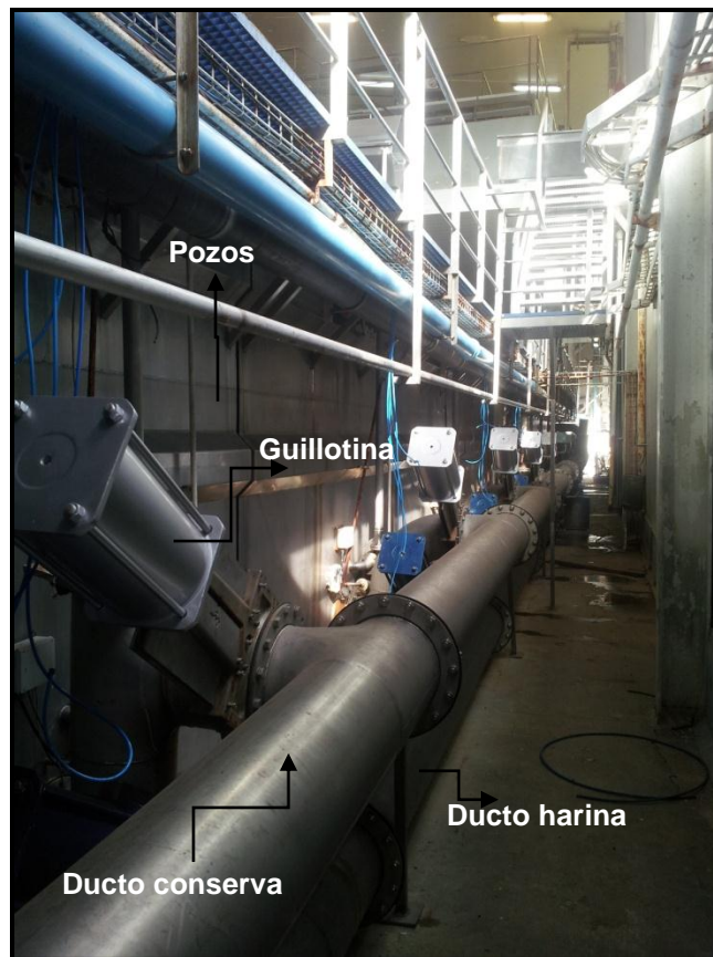
Figura 3.6. Disposición de actuadores de guillotina.
