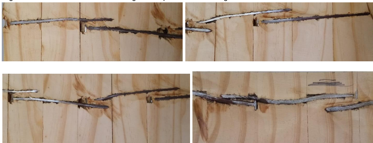
Figura 28. Detalle de deformaciones en clavos.
