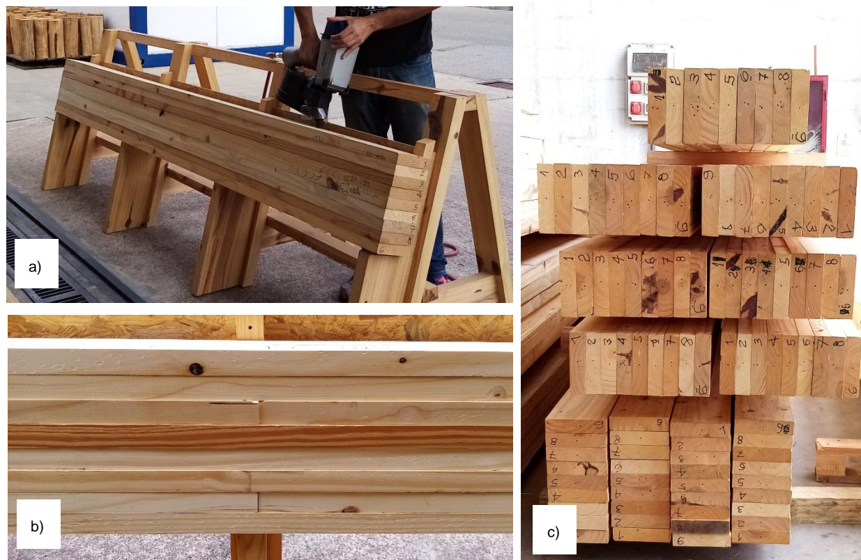
Figura 32 Características constructivas de los paneles y su armado. a) Clavado de la última lámina; b) detalle de juntas a tope ("Butt joints"); c) placas.
