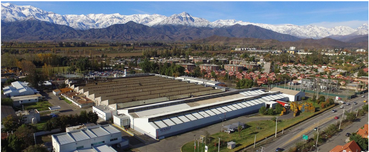
Figura II-1 Renault Usina Cormecánica, Los Andes
