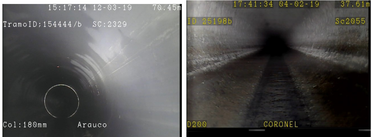
Figura 51: Imágenes en buen estado de tuberías Fuente: (Inggepro Ltda., 2019)
