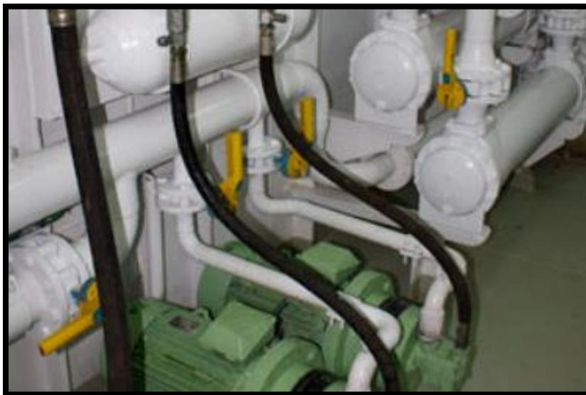
*Ilustración 34 Unidad hidráulica obtenida de la empresa Th Company.*
