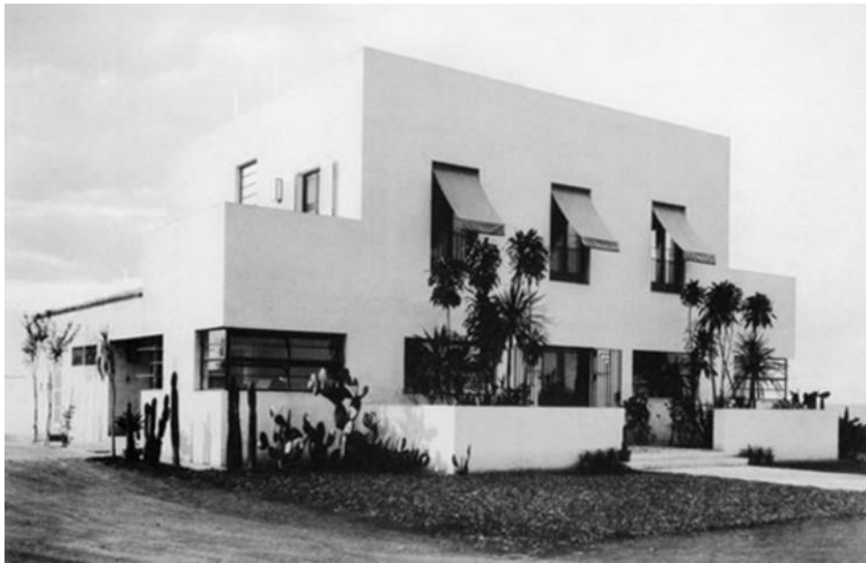
Figura 1. Casa modernista diseñada por Gregori Warchavchik, construida en San Pablo en 1928. Fuente: https://www.archdaily.com.br/br/764818/em-foco-gregori-warchavchik
