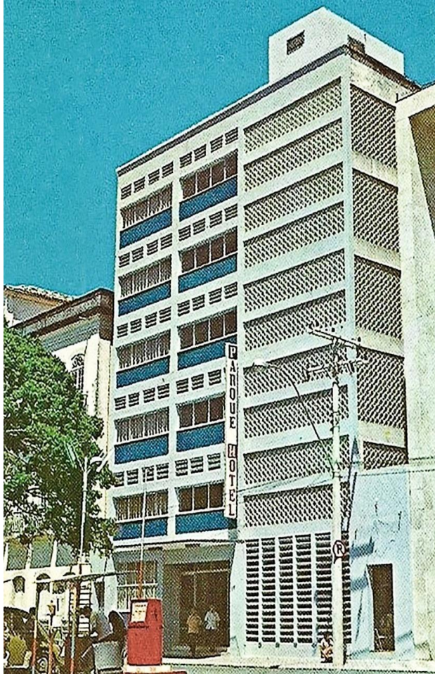
Figura 53: Fachada de acceso al Parque Hotel. Se destaca la piel de cobogós que protege las pasarelas del pavimento tipo. Fuente: Silva, 2018.
