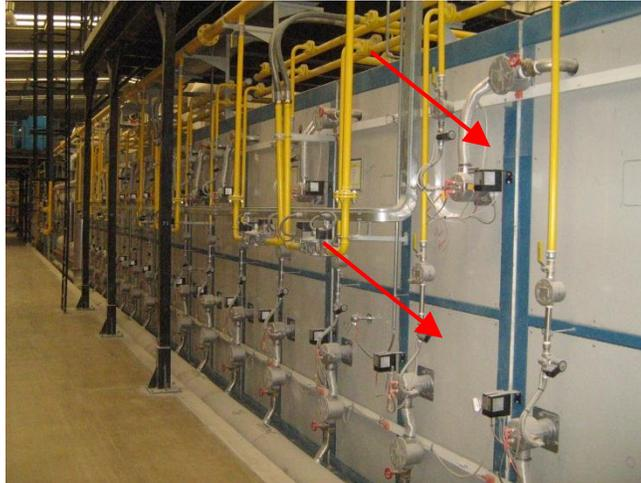
**Figura 3.10** Quemadores en Zona de Quema o Cocción.
