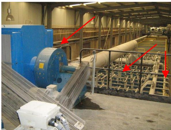
**Figura 3.7** Ventilador de Destratificación e inyección superior como lateral de aire ambiente.
