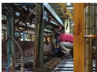
Imagen 4.23: Operador raspando guías de traspaso
