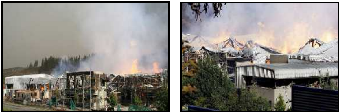
Figura 3.1: Siniestro afectando la Planta.
