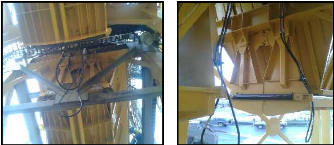
Fig. 7.9: Silos al momento del flushing.
