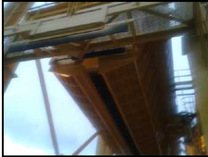
Fig. 7.14: Prueba Final de Abertura y Cierre de Silos.
