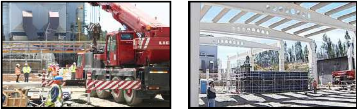
Figura 3.2: Etapa de reconstrucción.
