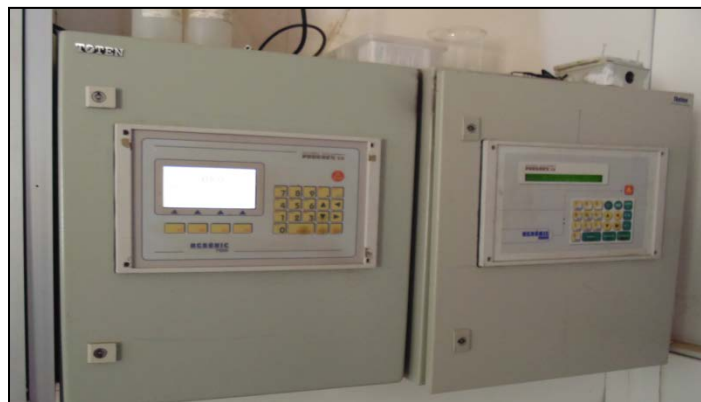
Fig 4.7 AGRONIC 7000 utilizado para controlar el riego.
