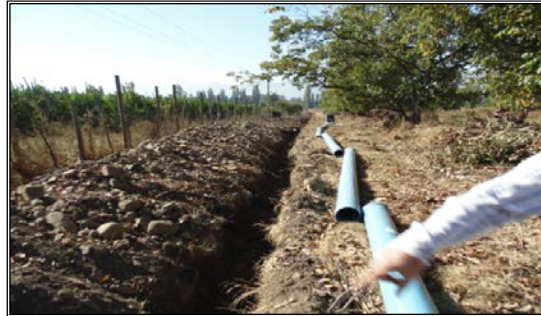
Fig. 1.4 Canalización de agua de pozo
