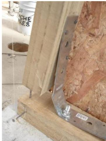
**Figura C 3. Deformación escuadra Simpson A66.**
