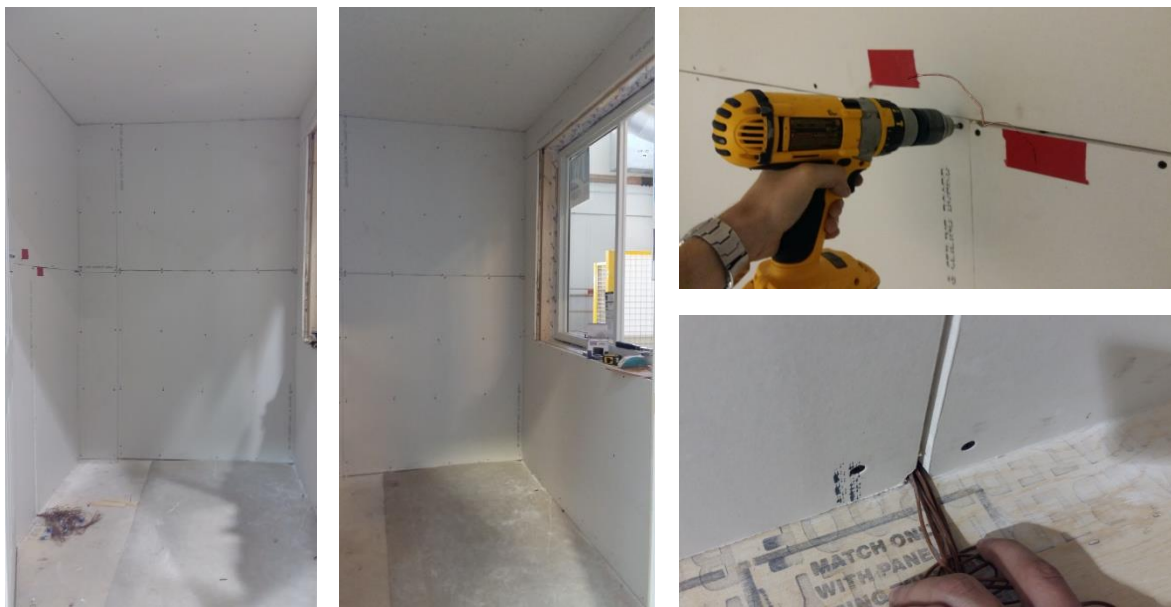
Figura 4.47: Colocación de yeso cartón y termocuplas interiores
