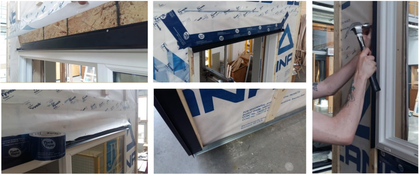
Fig. 4.48 Perfiles metálicos de soporte de revestimiento en cubículo de prueba.
