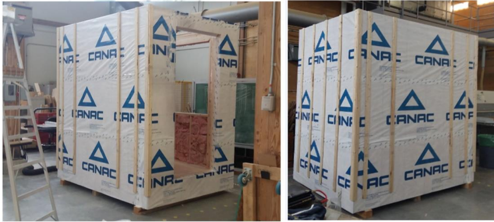
Figura 4.41: Colocación de barrera hidrófuga y listones de sujeción en cubículo de prueba
