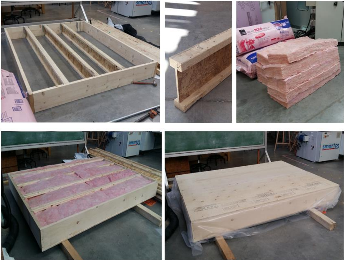
Figura 4.39: Construcción del piso del cubículo de prueba
