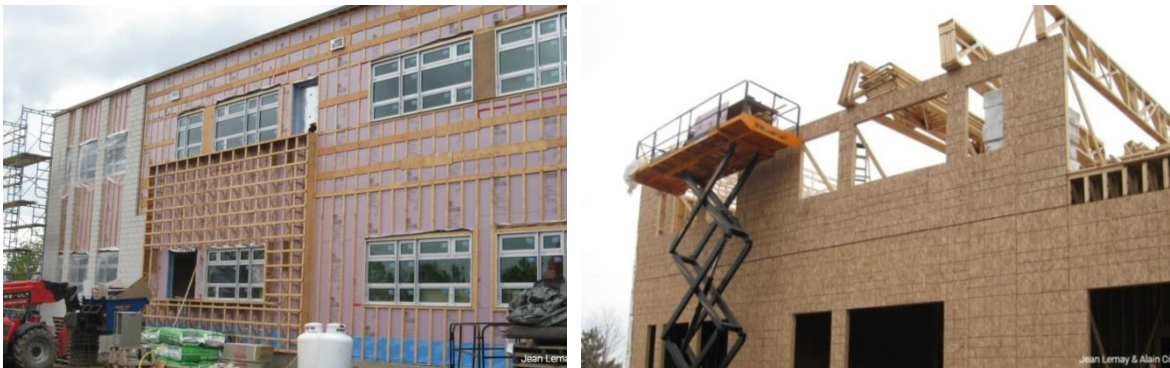
Figura 3.2: Colegio "Notre-Dame de bois franc" en fase de construcción
