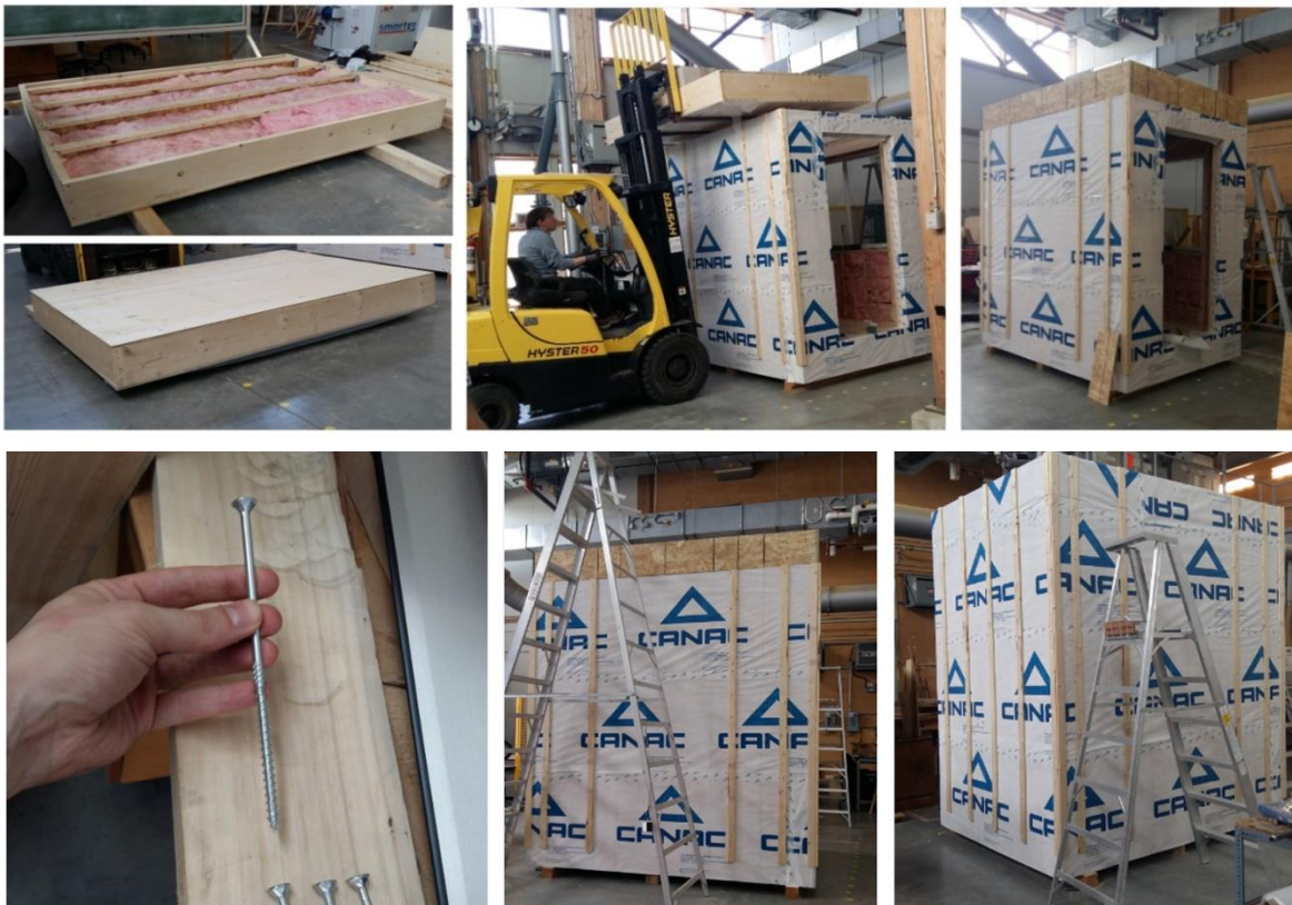
Figura 4.42: Construcción y montaje del techo del cubículo de prueba
