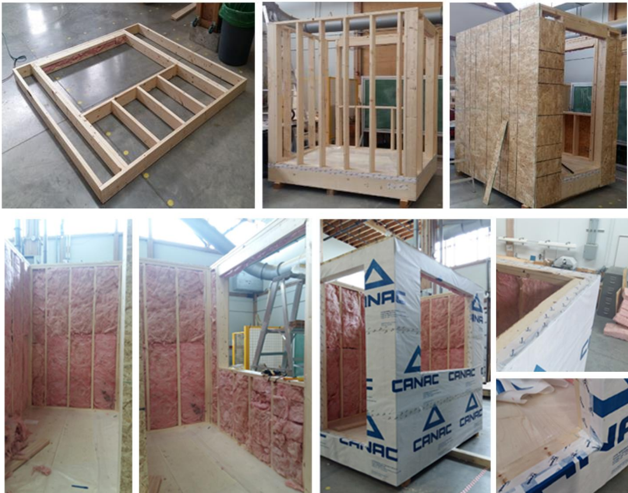
Figura 4.40: Construcción, montaje de muros y aislación interior del cubículo de prueba
