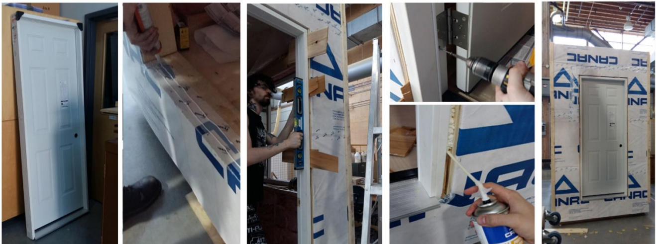
Figura 4.43: Colocación de puerta en cubículo de prueba.
