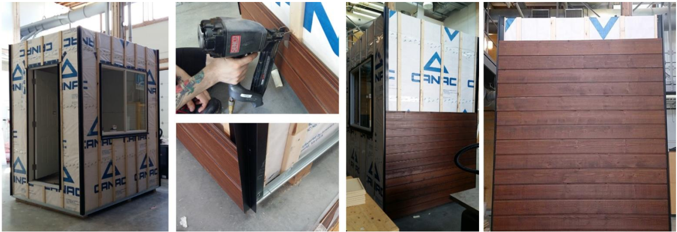
Figura 4.49: Colocación del siding en superficie exterior del cubículo
