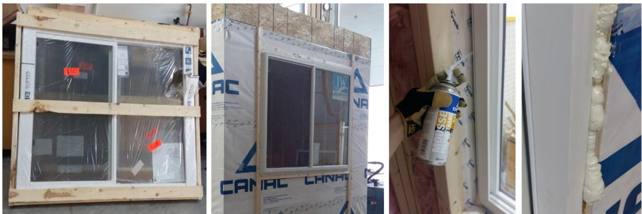
Figura 4.44: Colocación de ventana en cubículo de prueba
