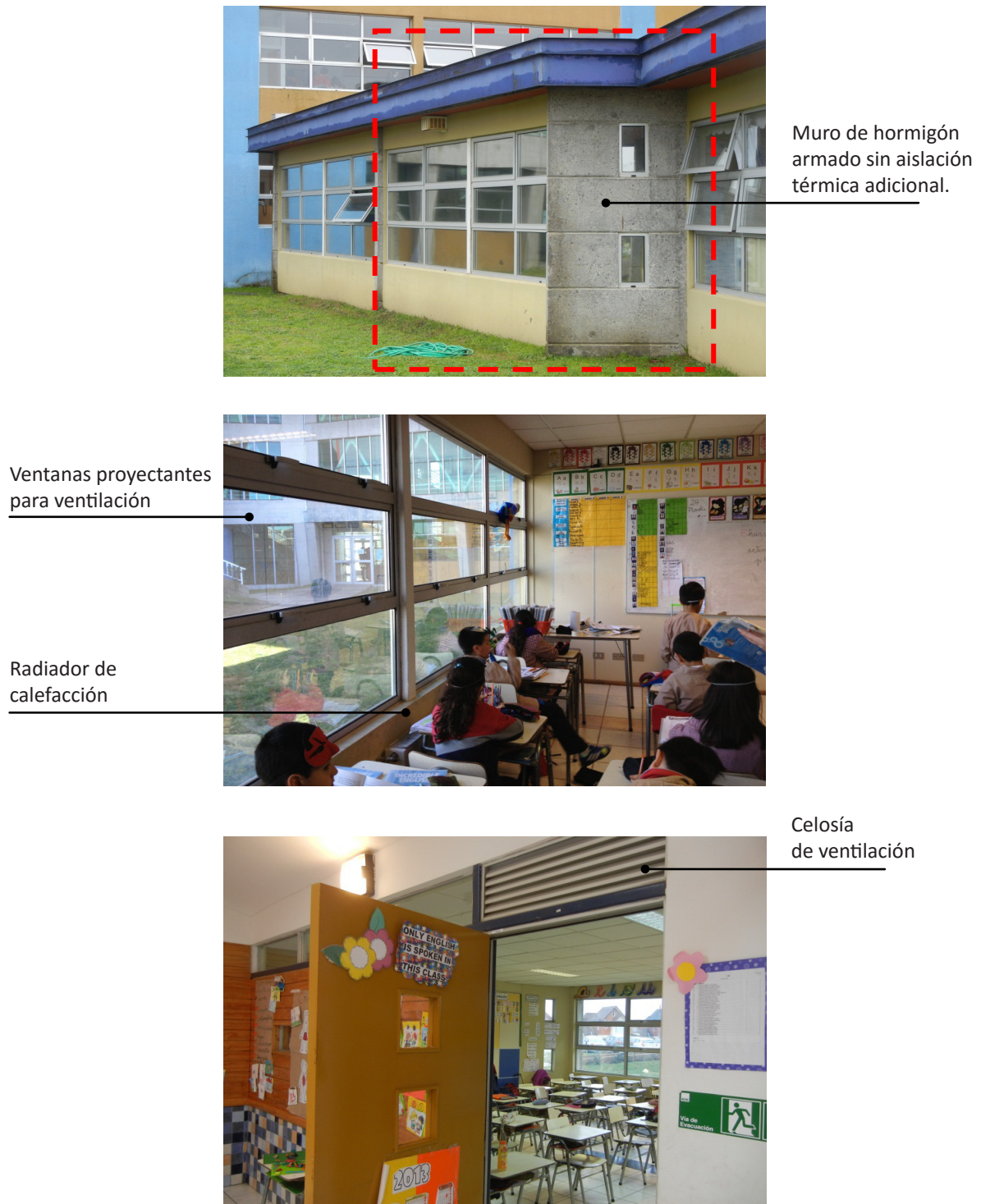
Figura 3.6: Fotografías exteriores e interiores del Caso A. Se aprecian los elementos que permiten calefaccionar y ventilar naturalmente.
