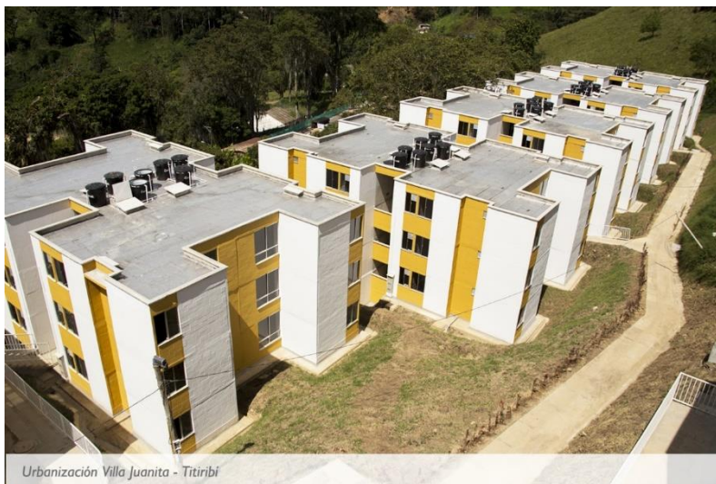
Figura 20. Vivienda multi-familiar con techo plano (losa de cubierta en concreto reforzado – (concreto + acero de refuerzo)).
