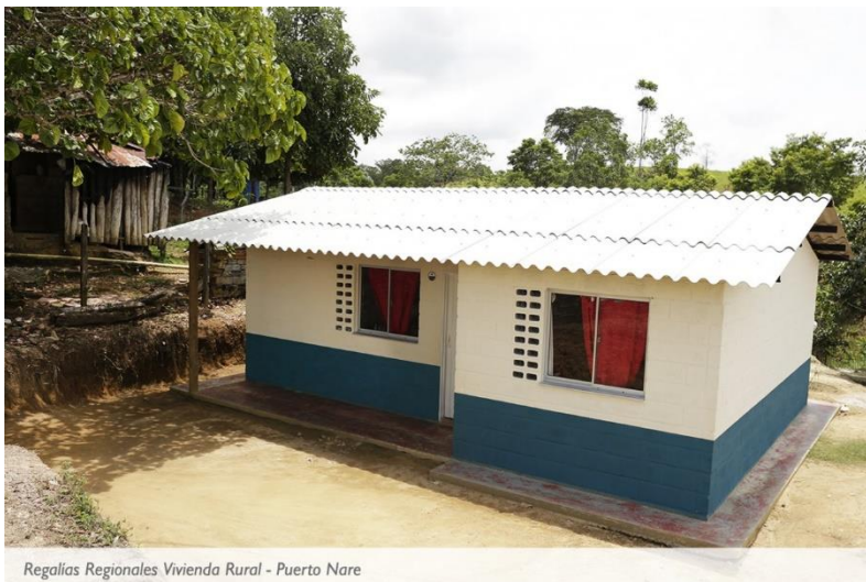
Figura 19. Vivienda unifamiliar con techo de Teja de Fibrocemento.
