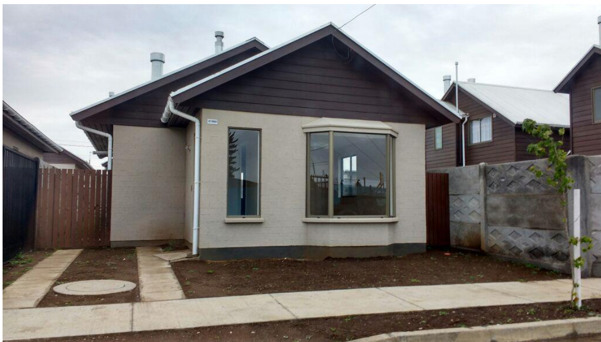
Construcción de vivienda de 57m 2 .
