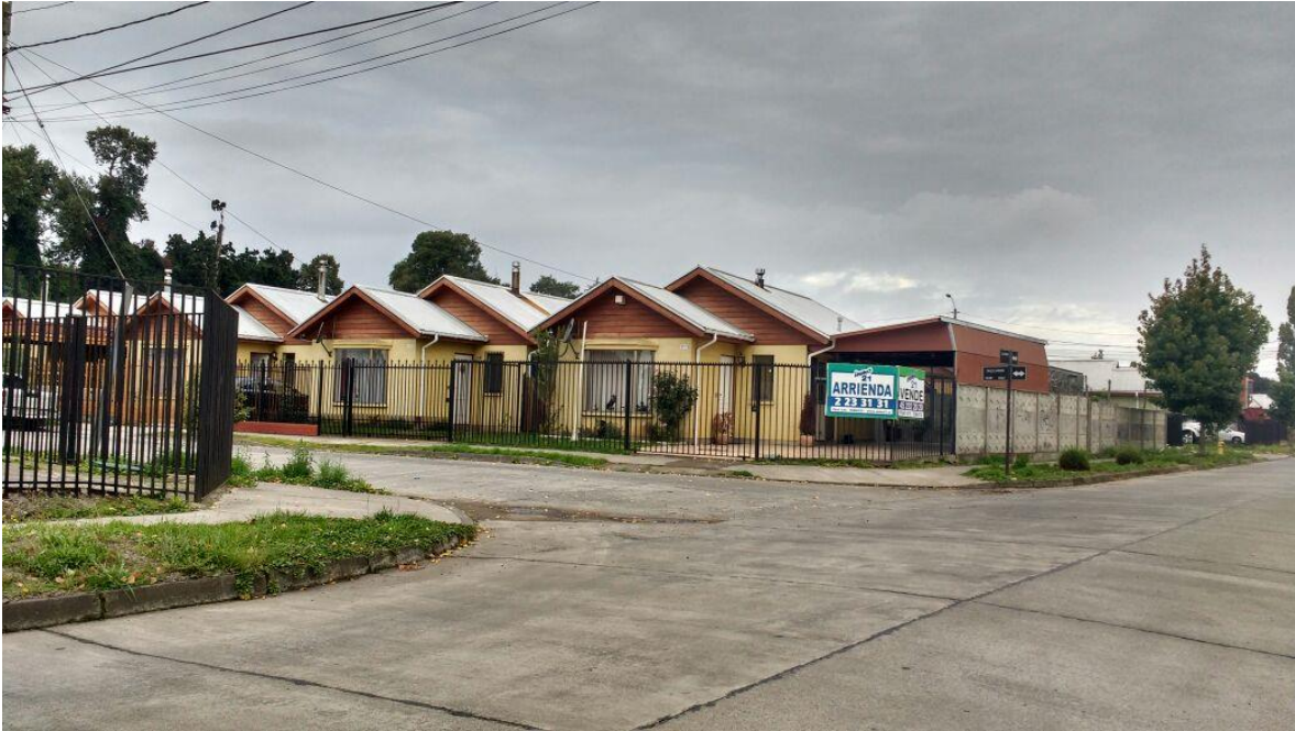
Construcción de vivienda de 57m 2 -etapa anterior.
