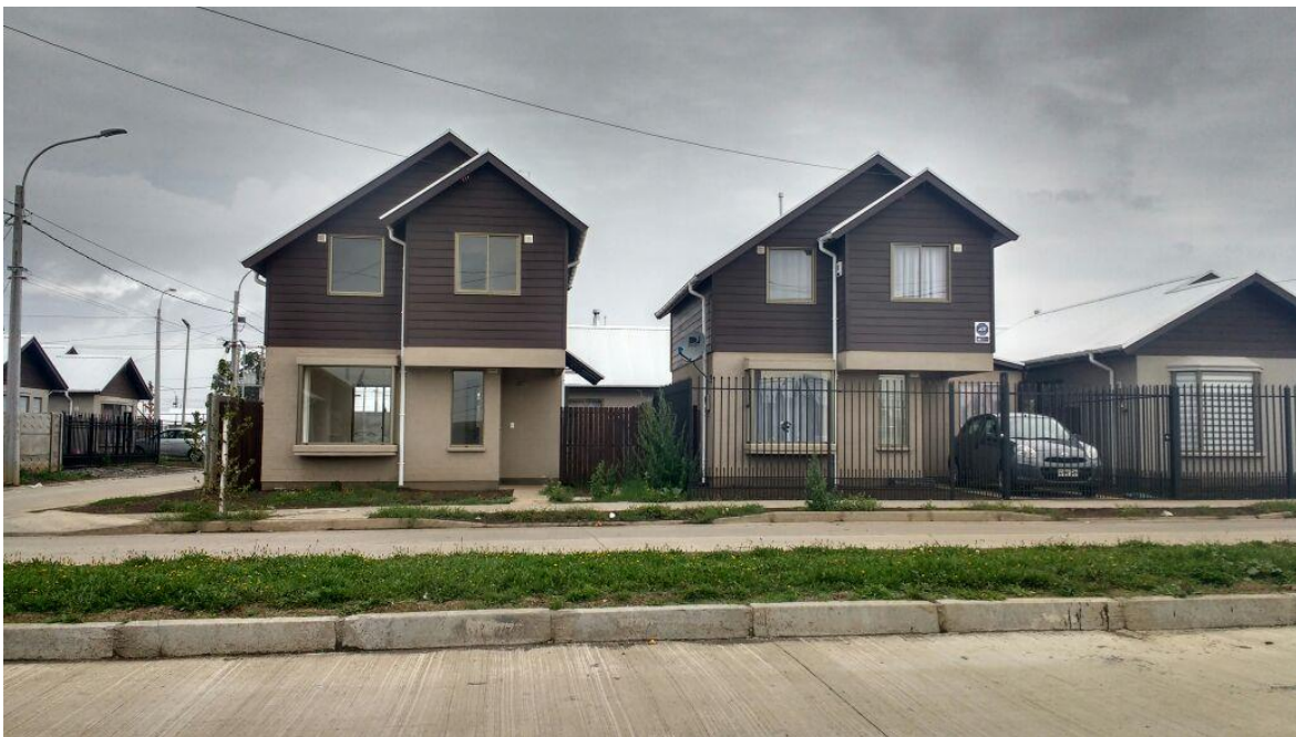
Construcción de vivienda de 64m 2 .
