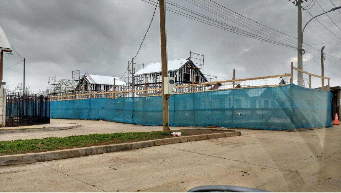
Construcción de viviendas de 64m 2 en futuras etapas.
