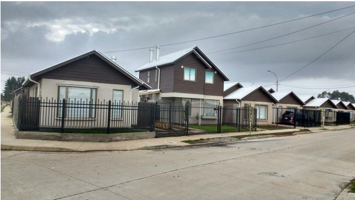
Construcción de vivienda de 57m 2 y de 64m 2 .
