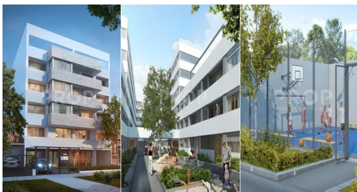
Figuras 2.6: Nuevos emprendimientos de Viviendas de Interés Social
