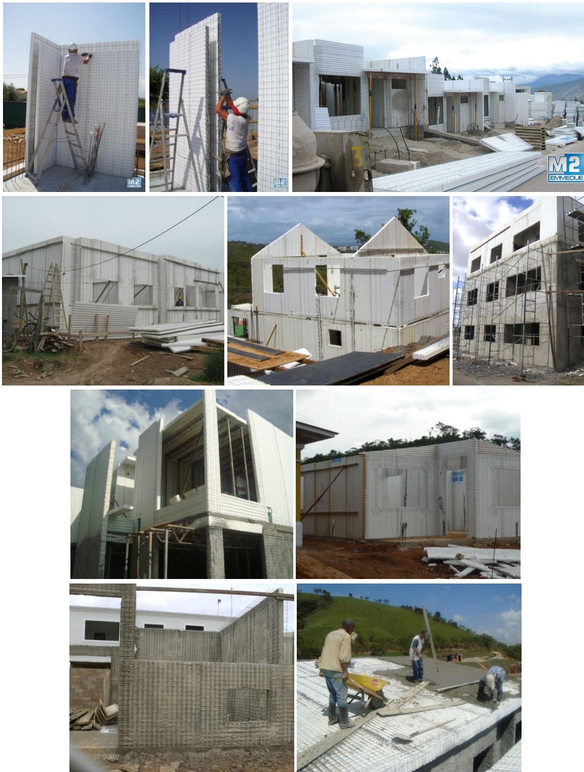
Figura C.3: Procedimiento constructivo SCNT 2 Fuente: SCNT 2
