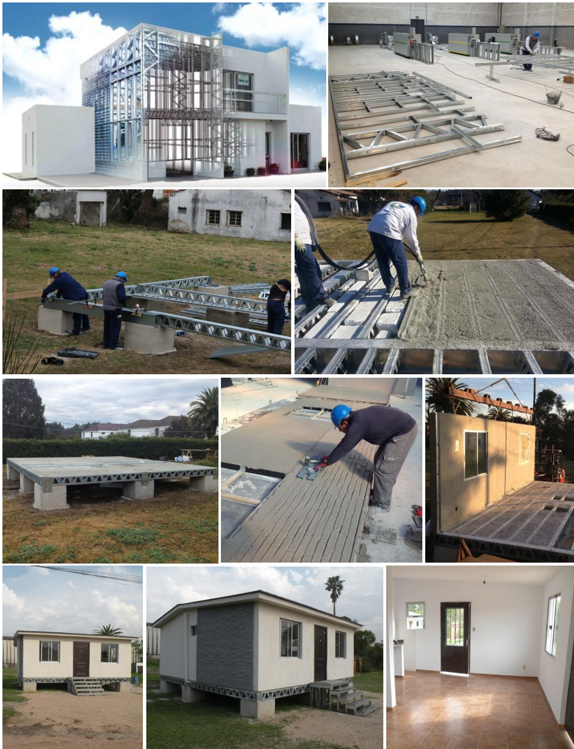
Figuras B.3: Procedimiento constructivo SCNT 1
