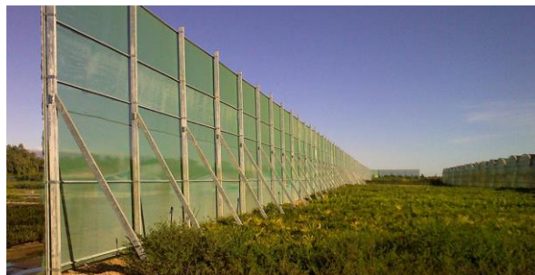
Figura 2.24: cortaviento móvil activado para proteger de vientos predominantes en periodos invernales
