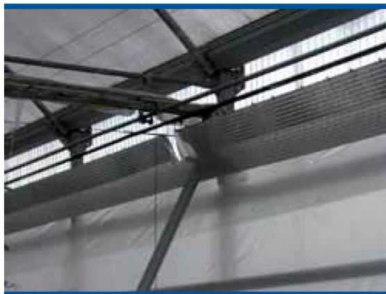
Figura 2.22: Láminas de sellado de las pantallas térmicas en su unión con los laterales del invernadero
