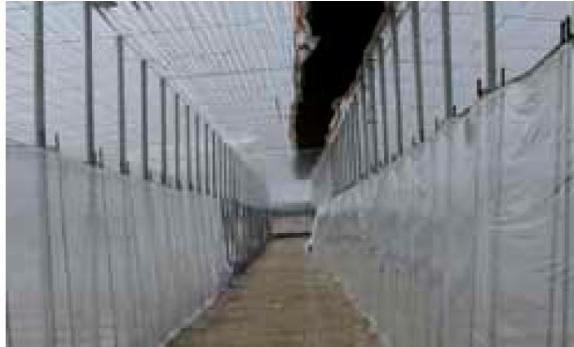
Figura 2.23: Particiones interiores con láminas de polietileno dentro de un invernadero
