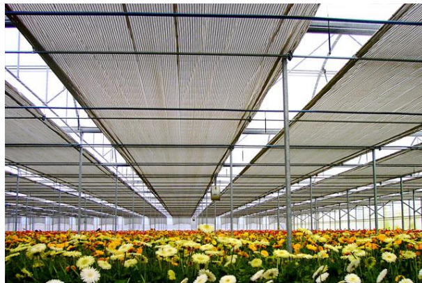
Figura 2.20: Invernadero con pantallas térmicas
