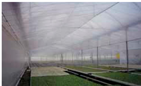
Figura 2.21: Instalación de un doble techo en un semillero comercial
