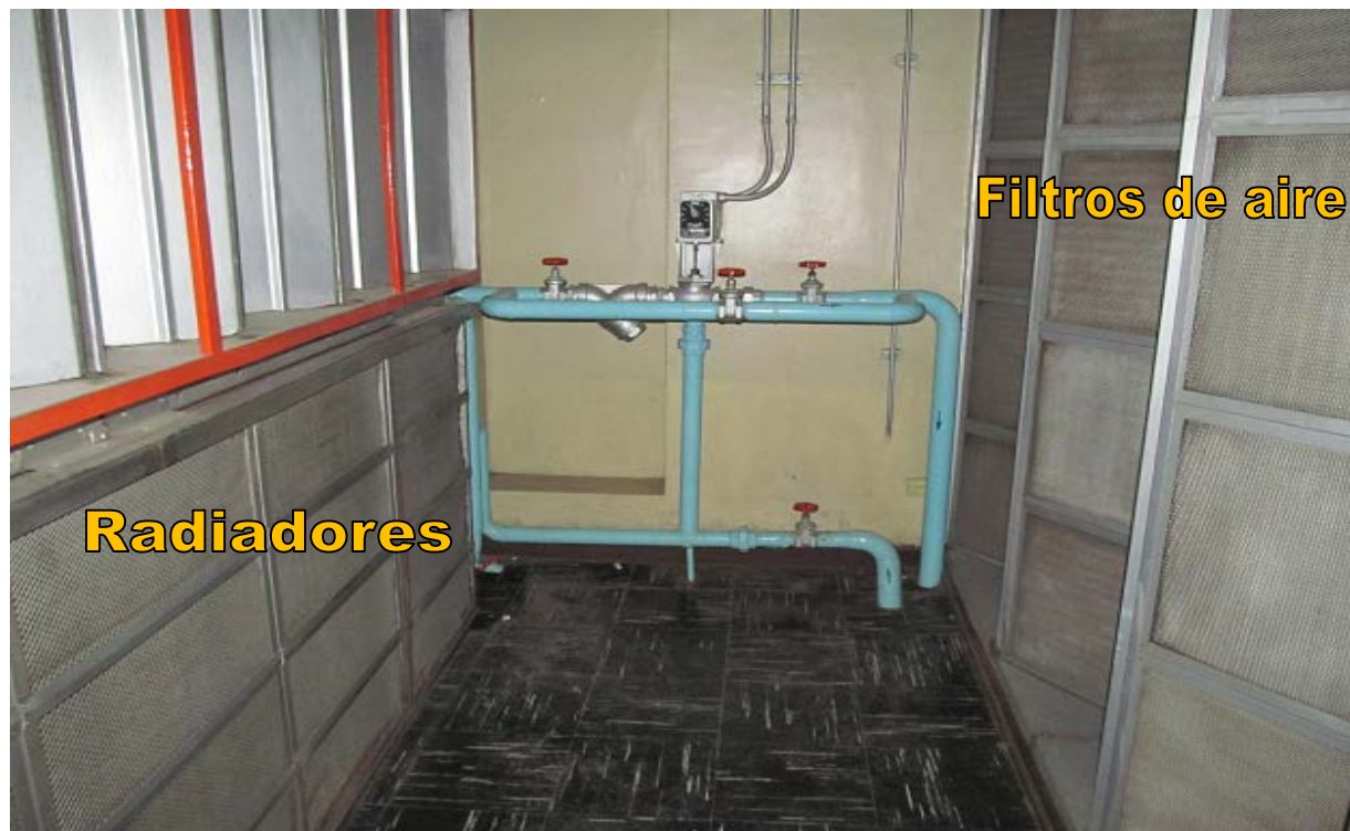
Figura 2.8. Climatizador, radiadores.
