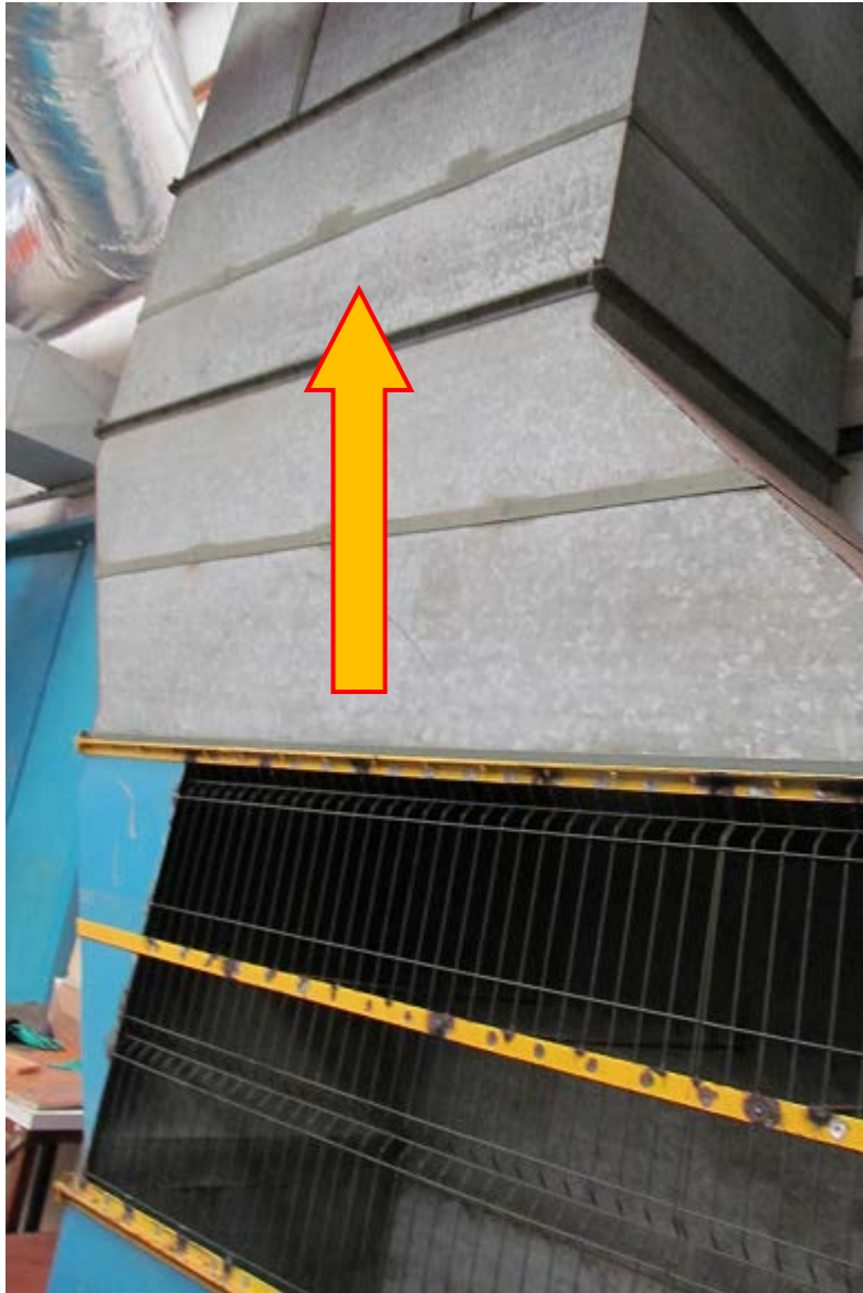
Figura 2.11. Boca de succión del aire recirculado.
