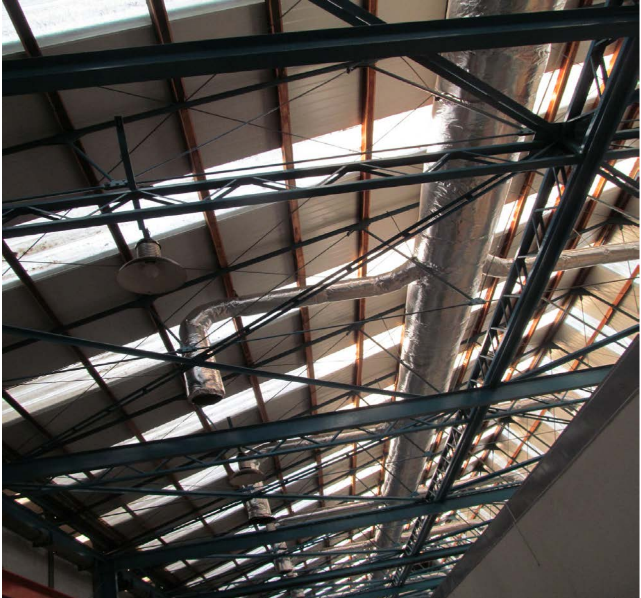
Fig. 2.2. Distribución de ductos al interior de la maestranza.
