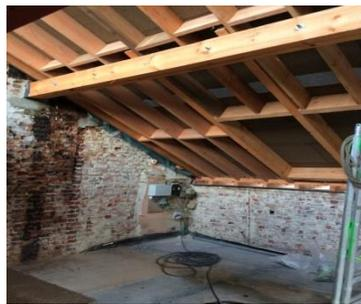
Reposición de estructura dañada en techumbre.
