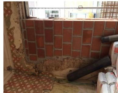
Reposición de parte del muro de albañilería original.
