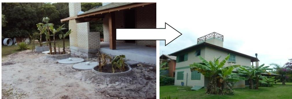
**Figura 9. Estanque de Evapotranspiración instalada y 8 meses después. (Fuente: autor)**
