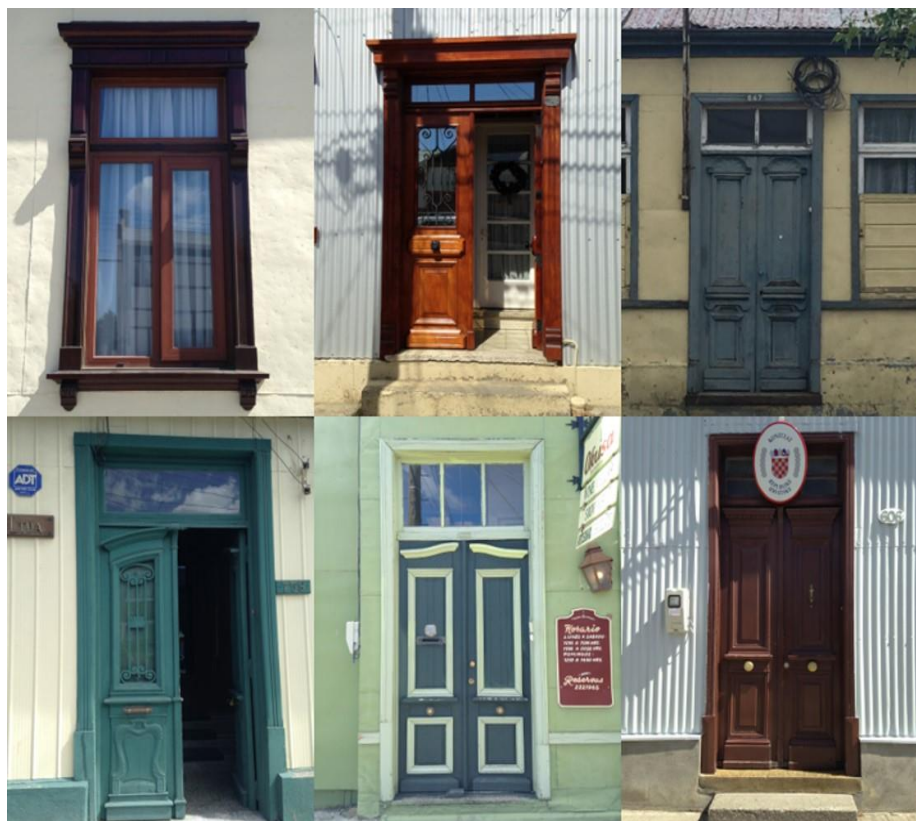
Figura 19: Set de fotografías de ventanas y puertas de viviendas tradicionales. Se aprecia uso de exclusiva o chiflonera de acceso con lucarna superior.
