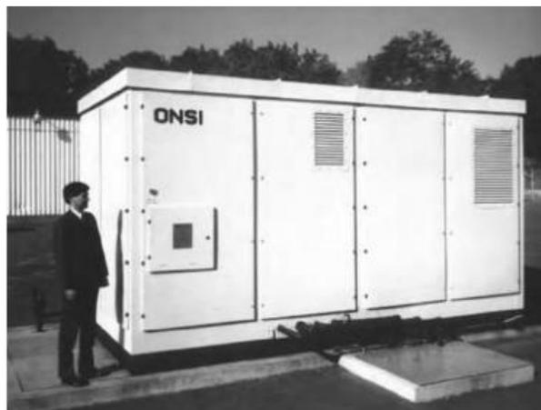
**Figura 3.5.7 “Celda de combustible de ácido fosfórico (Genera 200kW de electricidad y 200kW de energía térmica)”**
