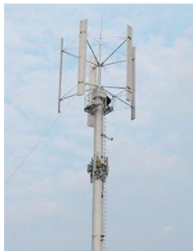
Figura 14 Turbina eólica de eje vertical de Darrieus tipo H.
