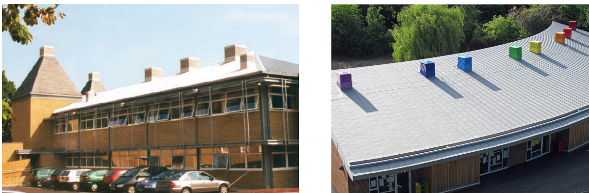
Figura 2.13: A la izquierda Windcatcher™ instalado en Kings Hill Offices, West Malling, Kent (fuente: www.monodraught.com ). A la derecha Windvent instalado en Castle Hill Primary School, Chessington, Londres (Fuente: www.mideng.net )
