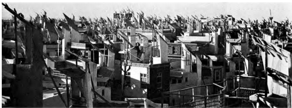
Figura 2.7: Captadores de viento en Hyderabad en Pakistán. (fuente: Rudofsky, 1964)
