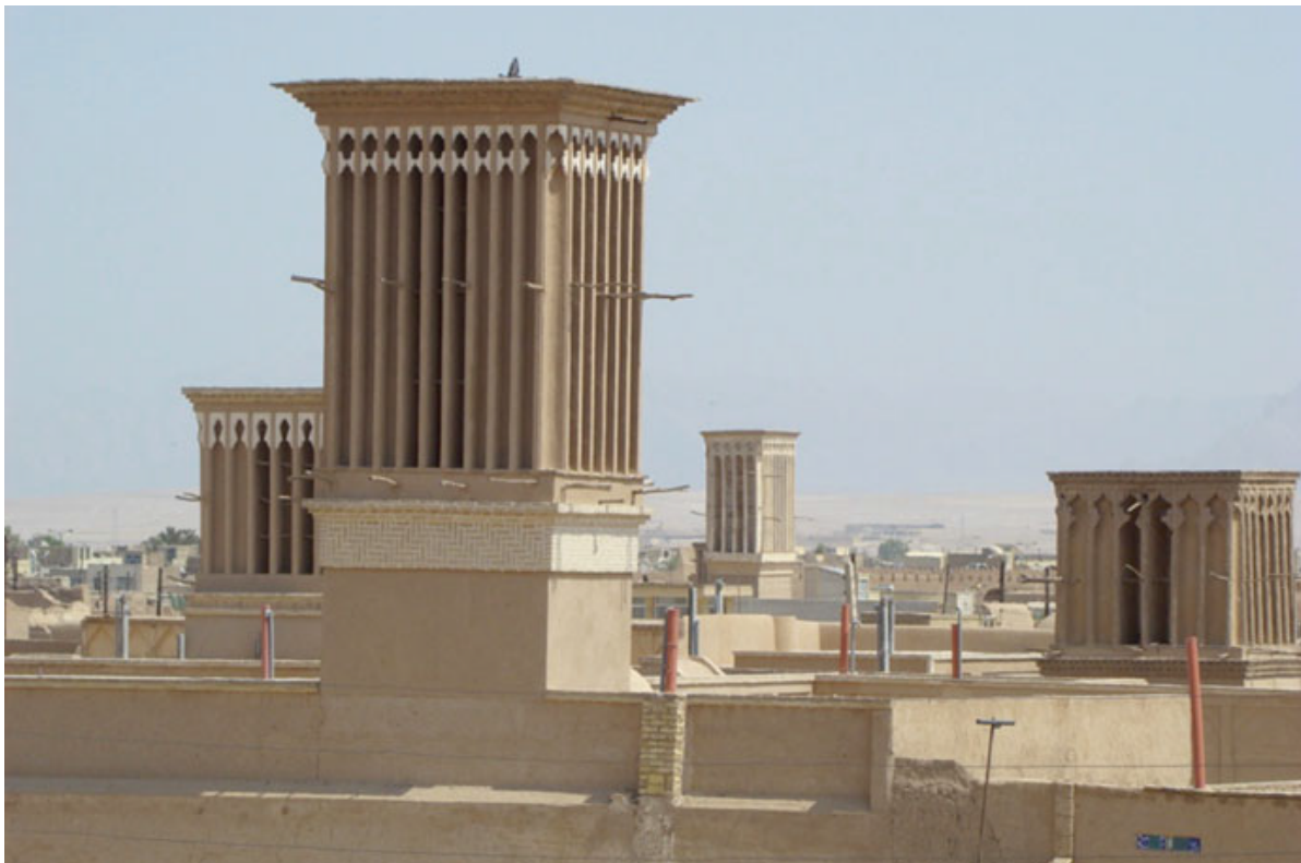
Figura 2.11: Acabados y ornamentos en las cabezas de torres de viento en un barrio tradicional de Yazd (Fuente: Bahadori et al. 2014)
