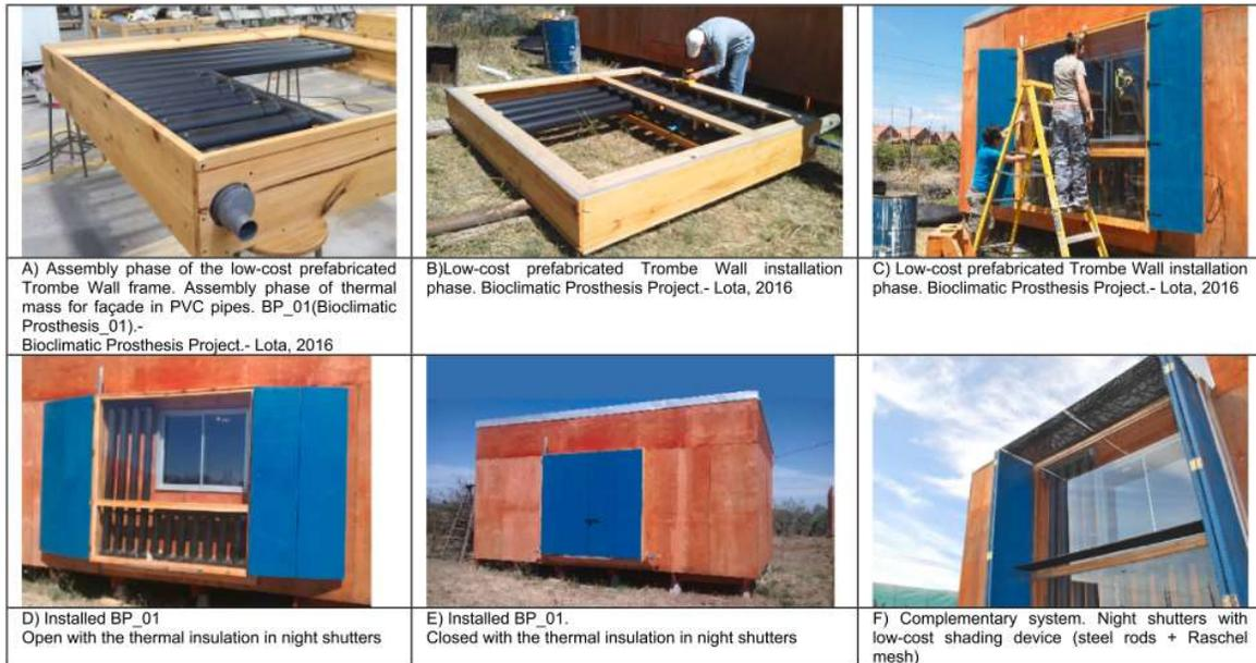
**Figura 5.** Fases de secuencia de construcción e instalación de la prótesis bioclimática en Chillan y Coronel (L. Agurto, Allacker, Fissore, Agurto, & De Troyer, 2020a).
