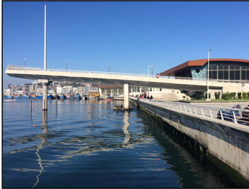
Figura 22. Imagen de Muelle Mirador – Zona N°5. Fuente: Elaboración Propia
