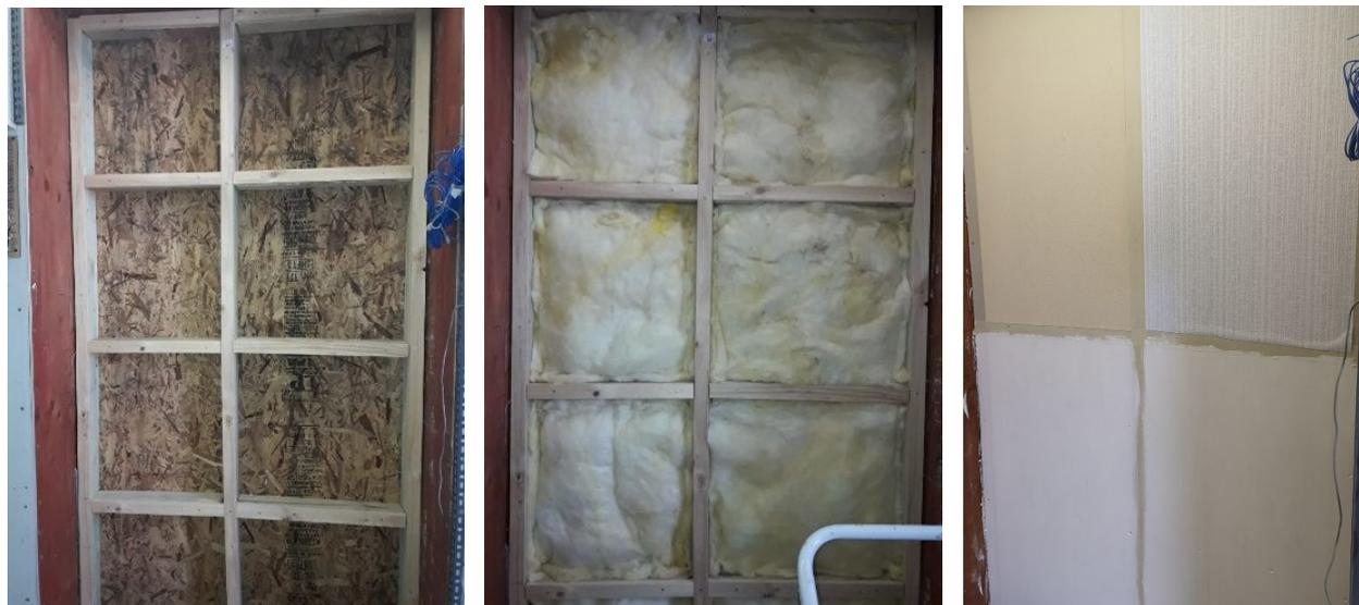
Figura N° 78: Fotografías de las etapas de la construcción del muro del caso de estudio.
