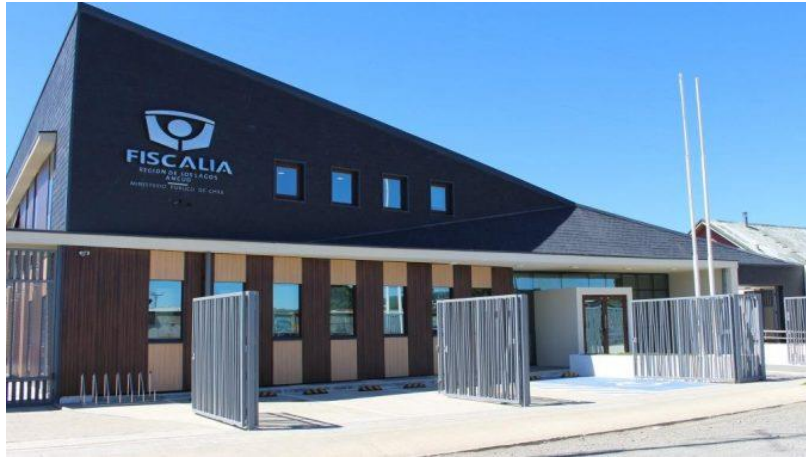
Figura 17: Vista exterior fachada Oeste Fiscalía Local Ancud.
