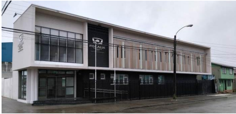
Figura 4: Vista exterior fachada Sur Fiscalía Local Cañete.
