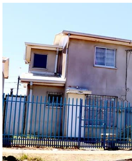
Figura 3.1. Vivienda pareada, conjunto habitacional Adela Ester
