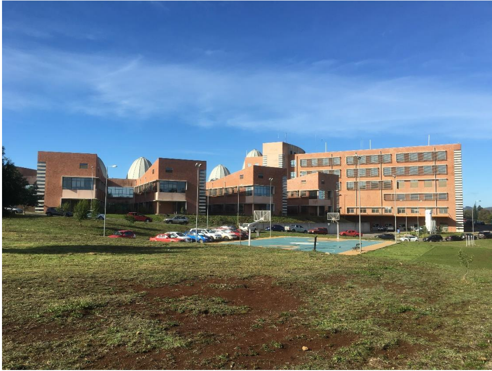
Figura 3.2. Fachada posterior orientación poniente del Hospital Intercultural Kallvu Llanka de Cañete.
