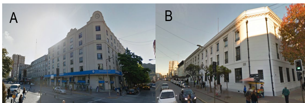
Fig. 9. A: Edificio esquina O'Higgins/Caupolicán; B: Edificio esquina O'Higgins/Rengo. Fuente: Google Street View.
