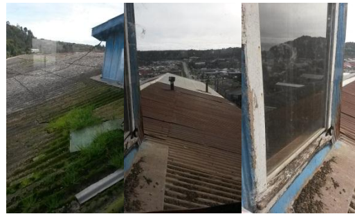
Figura 6: Complejo de Techumbre (autor 2016)
