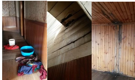
Figura 8: Cielo raso y muros (autor 2016)
