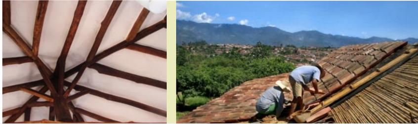
**Fig 9.** Construcción de techo a dos aguas con caña brava y teja de barro. Extraído de <http://www.arquitecturadecasas.info/>
