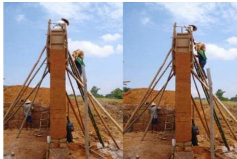
**Fig 8.** Construcción de muros con tapia pisada. *Extraído de*
