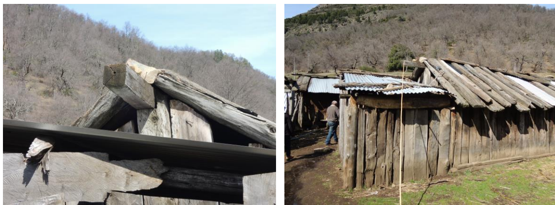
Imagen 14 y 15: Viga cumbre. Imagen 15: Vista general. Fuente: Archivo personal, año 2014
