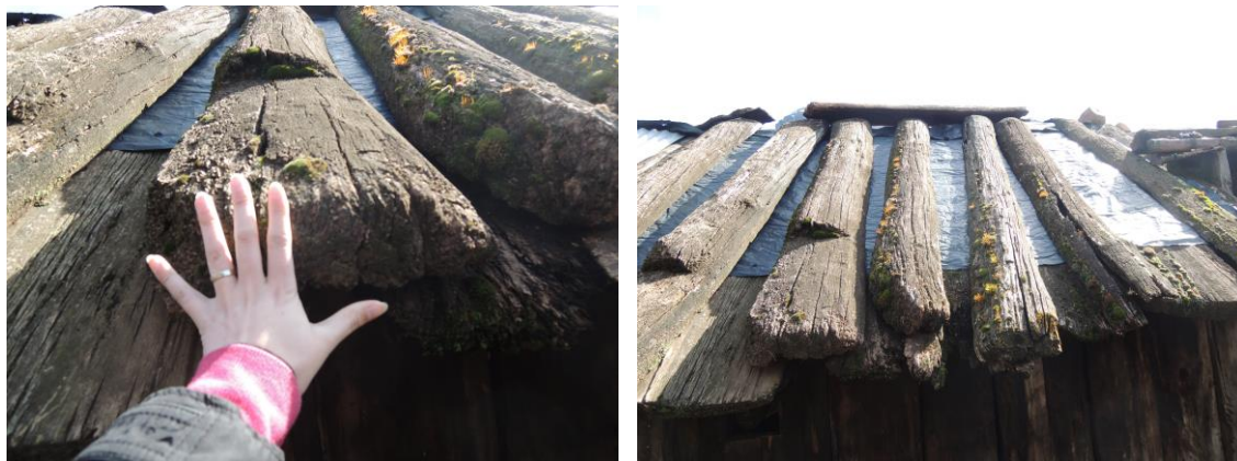
Imagen 12 y 13. Canogas o canoas en cubiertas ruka Pehuenche. Fuente: Archivo personal. 2014
