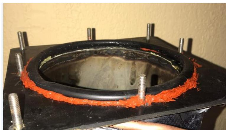
Figura 12. O-Ring de sello tapa superior adherido con silicona roja.
