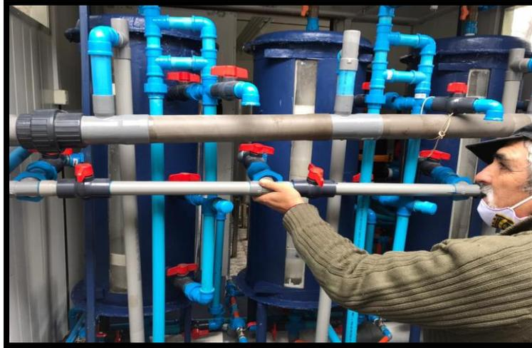
Figura 11. Desmontaje del sistema de fotobiorreactores.
