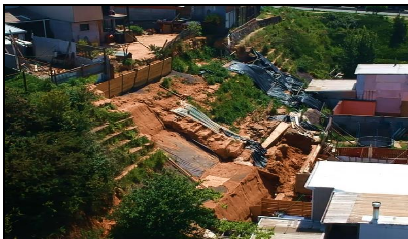
Figura 14. Talud 01 Población Geochile, Lirquén.
