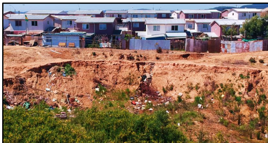
Figura 7. Talud N°01, Población Montahue, Penco.
