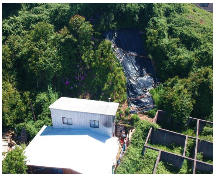
Figura 17. Talud 04. Población Jaime Lea, Penco.
