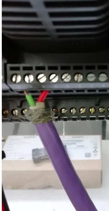
Figura N°13: Conexión de cable Profibus
